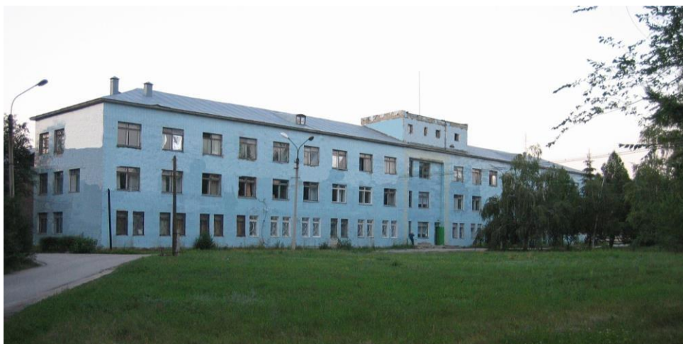
Главный корпус Центральной районной больницы
